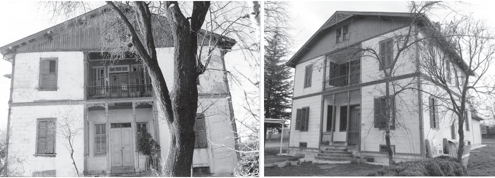
Bahattin Öğütmen konağı restorasyonu öncesi ve sonrası (1993-2013)
