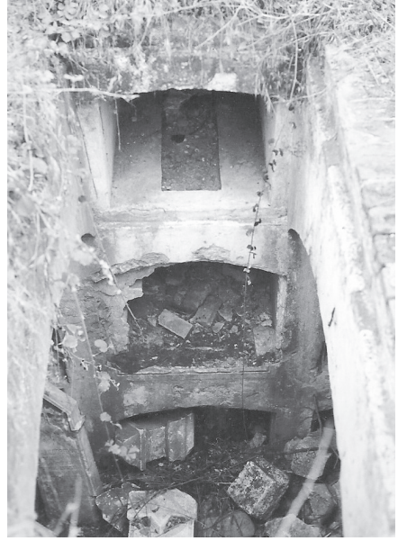
Katolik kabristanı mezar şapeli alt yapısının fotoğrafı (1994)
