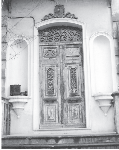
Giriş ve kapı detayları
