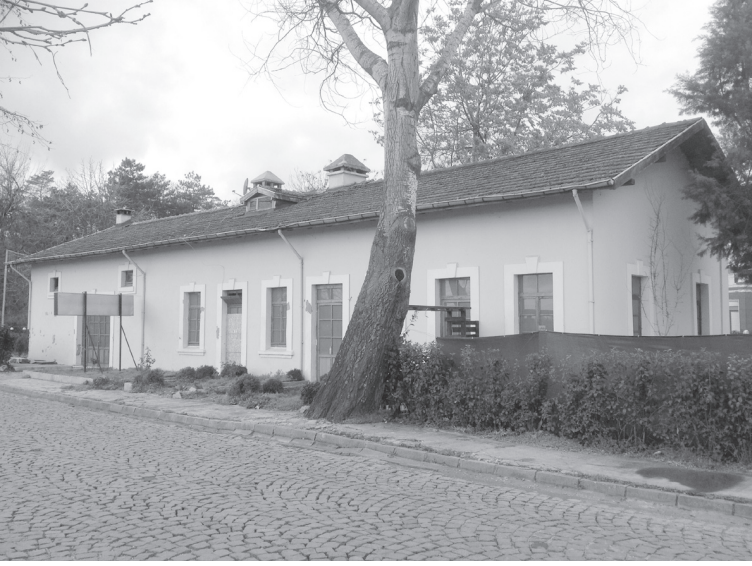
Küçük şehir istasyonun restorasyon sonrası (2103)
