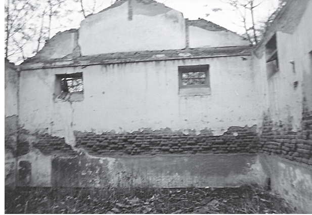
Edirne küçük şehir istasyonun restorasyon önceki bir fotoğrafı (1995)
